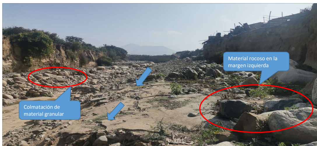
FIGURA N°05: CAUCE DE LA QUEBRADA LUMBRA, SE ENCUENTRA COLMATADA DE MATERIAL ROCOSO Y GRANULAR, POR LO QUE EXISTE UNA REDUCCIÓN DE SU SECCIÓN HIDRÁULICA, CAUSANDO UN DESBORDAMIENTO ANTE UNA EVENTUALIDAD DE MAXIMAS AVENIDAS.
