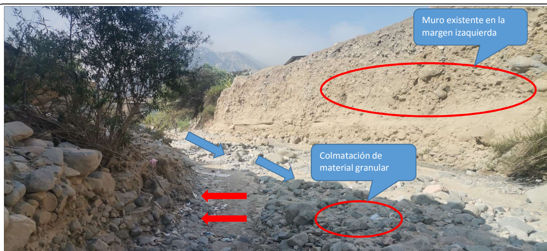
FIGURA N°03: TRAMOS EN LA MARGEN DERECHA DE LA QUEBRADA LUMBRA EN EL SECTOR LUMBRA CON MATERIAL GRANULAR, OCASIONA QUE EL DESBORDAMIENTO DEL CAUCE DEL RIO SEA MAS INMINENTE EN EPOCAS DE AVENIDAS.
