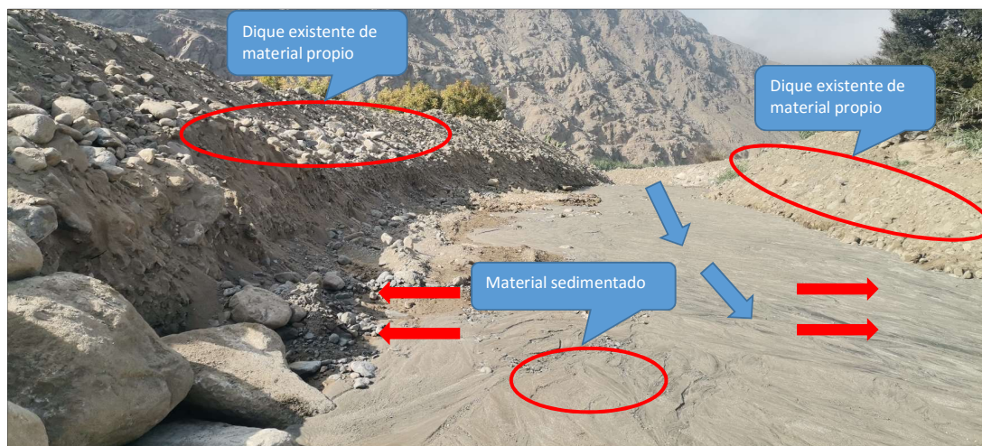
FIGURA N°02: AMBOS MARGENES DE LA QUEBRADA LUMBRA PRESENTA DIQUE DE PROTECCIÓN EN BUEN ESTADO, EN EL SECTOR LUMBRA DEL DISTRITO DE HUARAL.
