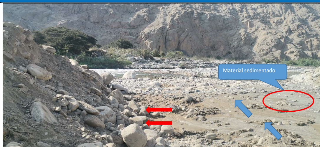
FIGURA N°01: QUEBRADA LUMBRA COLMATADO EN EL SECTOR LUMBRA, CON LA PRESENCIA DE MATERIAL FINO SEDIMENTADO; LAS CUALES DEBEN SER DESPLAZADOS HACIA AMBOS MARGENES PARA MANTENER SU SECCIÓN HIDRÁULICA .
