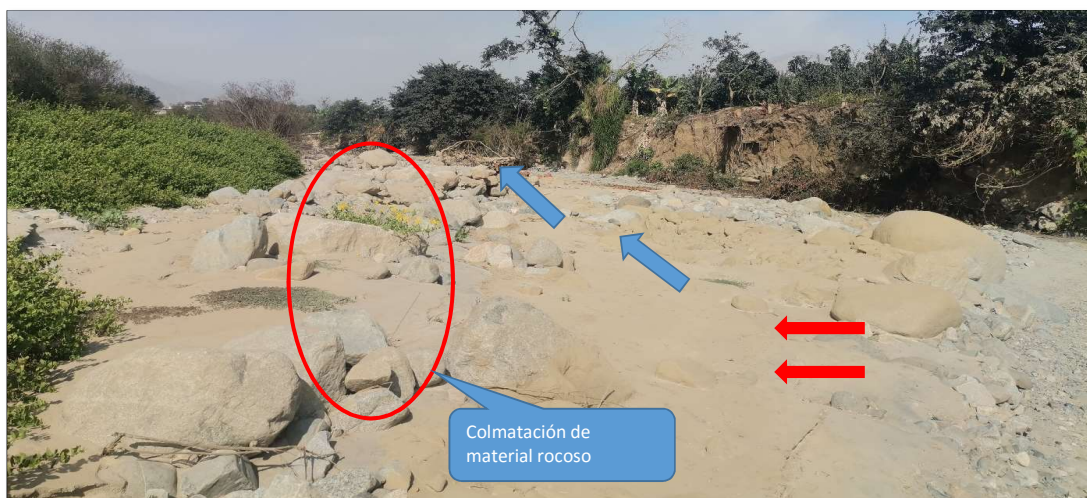
FIGURA N°06: TRAMOS EN LA MARGEN IZQUIERDA DE LA QUEBRADA LUMBRA CON MATERIAL ROCOSO, OCASIONA QUE EL DESBORDAMIENTO DEL CAUCE DEL RIO SEA MAS INMINENTE EN EPOCAS DE AVENIDAS.
